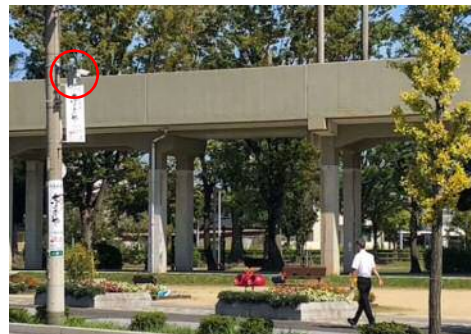
防犯カメラが設置された公園
