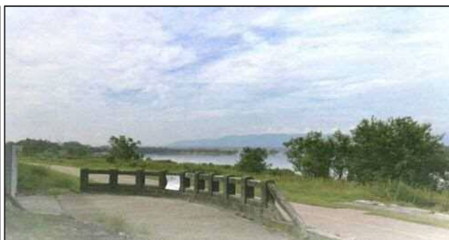
図 川原に樹林や草本が生い茂る現在の木曽川（起宿周辺）
