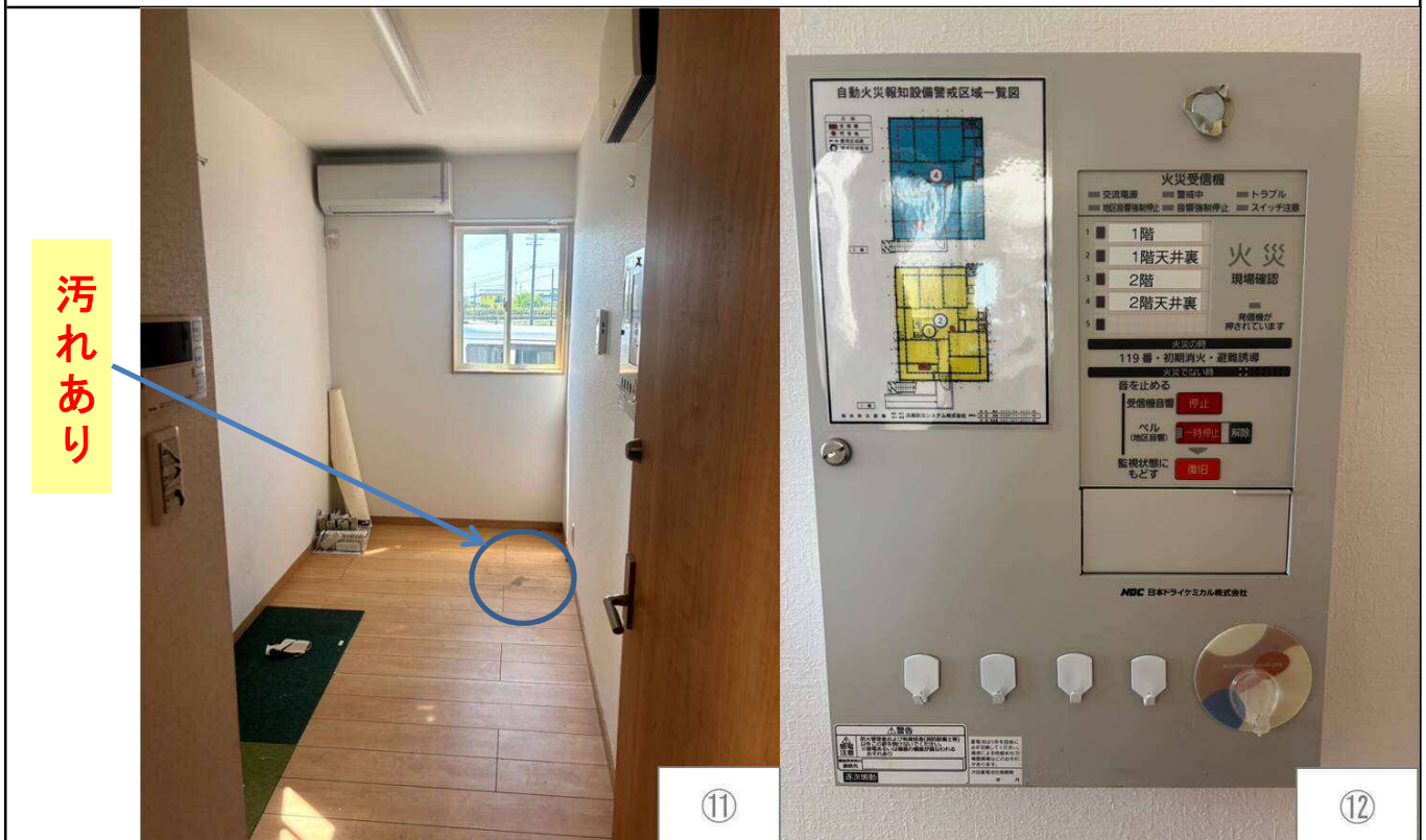
写真⑥ 1階事務室、消防設備
