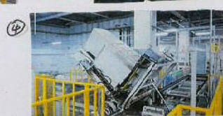
手解体後横にして石破砕機へ投入
