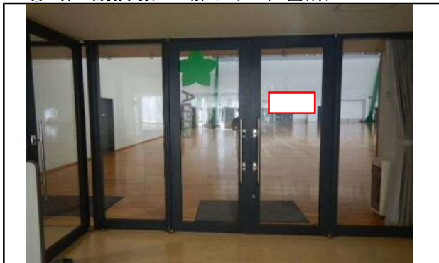
2-③ 第2競技場入口扉サイン(1箇所)
