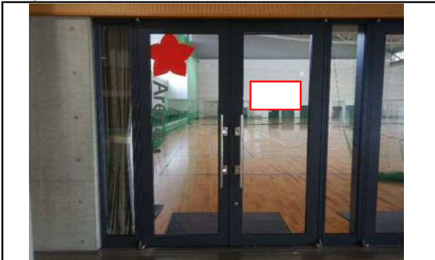
3-③ 第3競技場入口扉サイン(1箇所)
