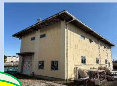
〔小信ポンプ場(旧西萩原ポンプ場)〕
